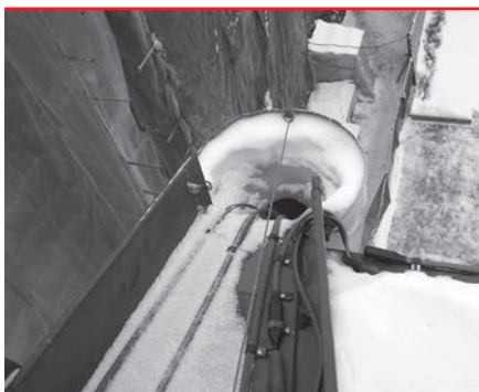
1 водометы и водометные окна в парапетах
