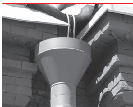
7 водосточные трубы и воронки
