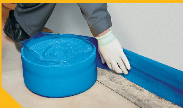
Лента наклеивается на нижнюю часть выровненной и отштукатуренной стены. Клеят ленту по всему периметру помещения, сплошным полотном, без пропусков.
