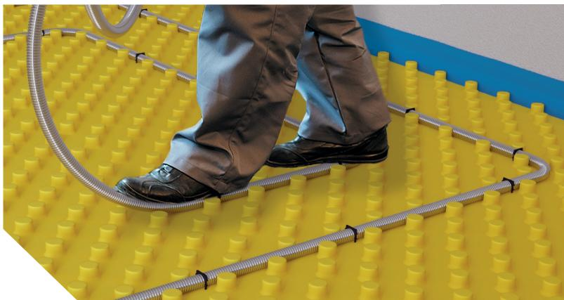
Укладка нагревательной трубы водяного теплого пола не требует специальных инструментов. При использовании матов с фиксаторами Stahlmann труба просто фиксируется между бобышками мата при нажатии на неё сверху.
